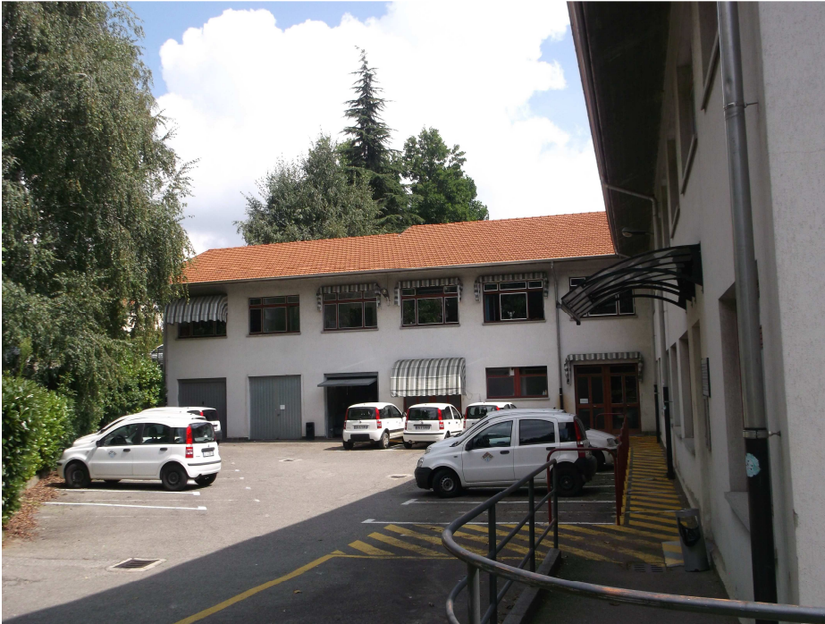
Facciata ovest – cortile interno
